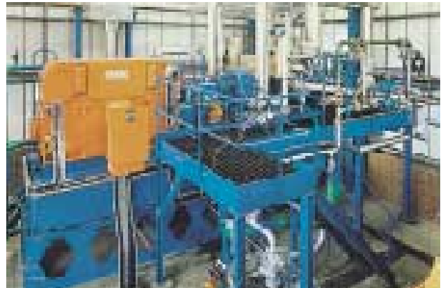
Acoplamiento PM40 en un generador de turbina a vapor Peter Brotherhood
