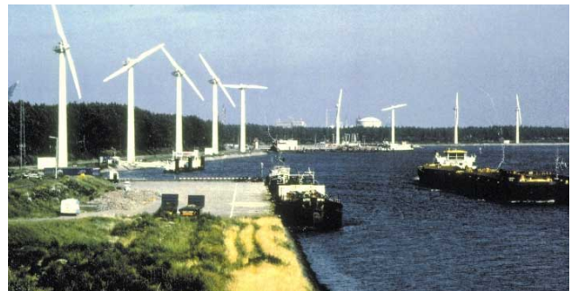
Acoplamiento RB 0.73 eje cardan y 0.73 eje a eje con miembro interior de núcleo largo, en planta eólica en los Países Bajos
